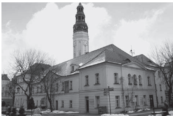
Fig. 1. View of the town hall from the south-west (photo: A. Legendziewicz) Il. 1. Widok ratusza od południowego zachodu (fot. A. Legendziewicz)
