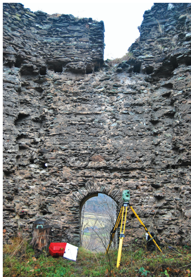
Il. 9. Wnętrze wieży ośmiobocznej w widoku na ścianę północną. Na powierzchni ścian czytelne negatywy bali oblicowania ciepłej izby; powyżej negatywy gniazd belek stropowych (fot. P. Błonieński)
