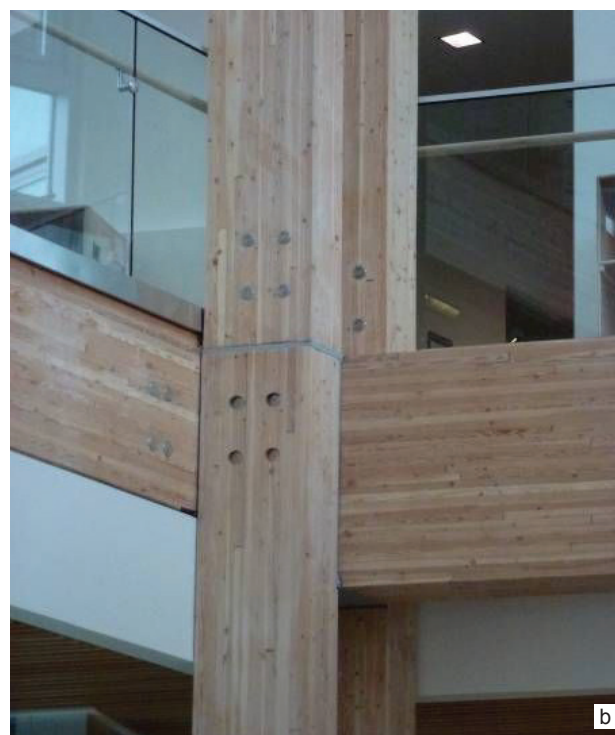
Il. 9. Wnętrza: a) widoczna drewniana konstrukcja holu i klatki schodowej, b) detal łączenia drewna umożliwiający łatwą rozbiórkę budynku Fig. 9. Interiors: a) wooden construction of the hall and staircase, b) detail of joining wood that facilitates easy dismantling of the building
