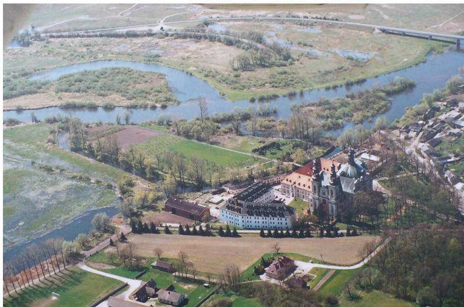
Il. 1. Dawne opactwo cysterskie w Łądz nad Wartą, widok od strony północno-wschodniej, u dołu teren dawnego ogrodu opackiego, w głębi ogród na wyspie, po prawej park przykościelny (fot. Z. Tomczak)
