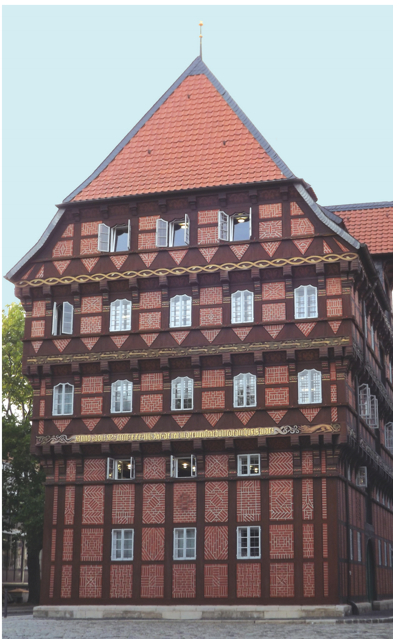
Dom Wagi w Braunschweig z ozdobnymi wypełnieniami fachów przez zastosowanie zmiennego wążku cegły (fot. D. Kowalska)
