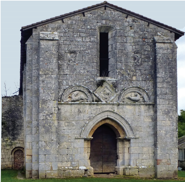
Il. 3. Elewacja zachodnia kościoła w Olerat, 2012 (fot. A. Evans)
