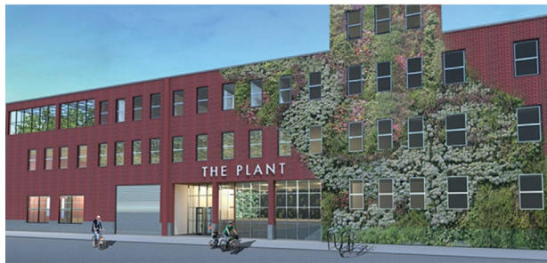
Il. 6. Chicago – farma hydroponiczna w rewitalizowanym budynku Peer Factory (źródło: [11])
