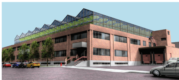
Il. 8. Montreal – zabudowa szklarniowa dla upraw hydroponicznych na dachu budynku przemysłowego. Projekt: GKC Architects 2010 r. (źródło: [13])
