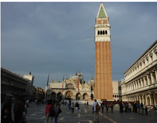
Il. 1. Plac św. Marka (fot. K. Strumiłło)
