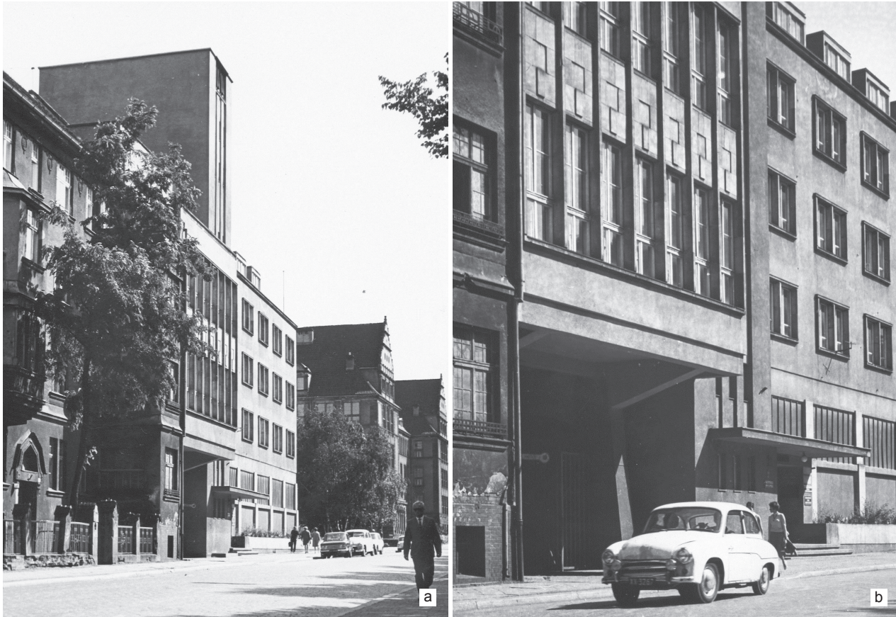
Il. 4. Wrocław, ul. Łukasiewicza, gmach główny Wydziału Mechanicznego: a) widok od strony frontowej, b) środkowa partia północnej części budynku (Archiwum Politechniki Wrocławskiej)
