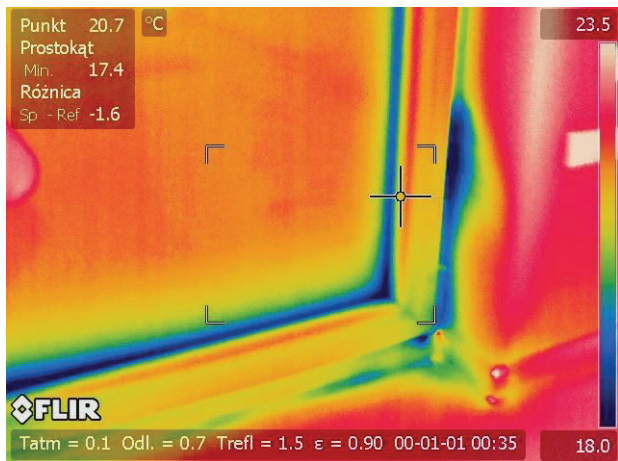
Il. 1. Wadliwy i nieuszczelny montaż okna powoduje znaczne obniżenie temperatury wokół stolarki okiennej
