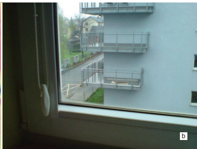
Il. 3. Skroplona wilgoć w połączeniu układu szybowego z ramą: a) termogram oraz b) zdjęcie rzeczywiste
