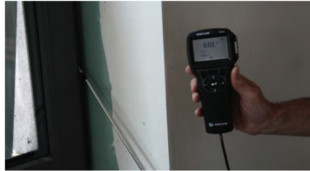
Il. 6. Monitorowanie przecieków przy użyciu anemometru
