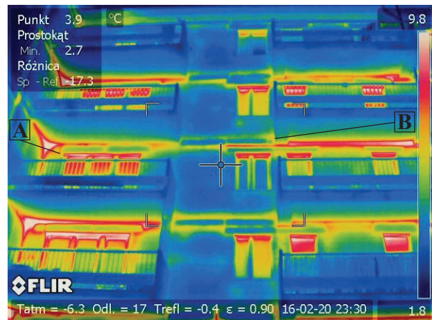
Il. 2. Mostki termiczne na połączeniu płyt balkonowych ze ścianą zewnętrzną (A). Dodatkowo widoczne niedociągnięcia ocieplenia elementów wieńca i nadproży (B)
