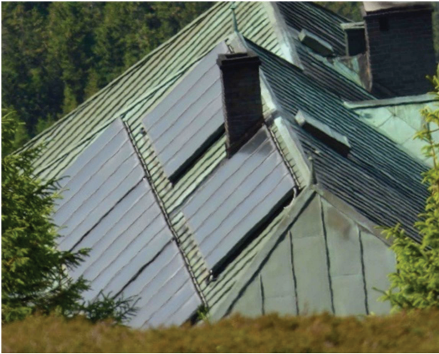
Il. 7. Kolektory słoneczne na dachu schroniska Strzecha Akademicka (fot. Ł. Simiczyjew)
