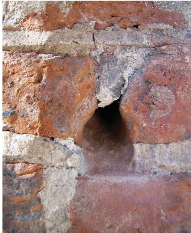
Il. 5. Otwór po metalowej wskazówce (polosie) na ścianie południowej transeptu kościoła Mariackiego w Gdańsku (fot. T. Jażdżewski, 2018)
