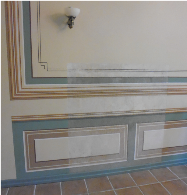
Il. 8. Dwór w Sylgudyszkach (Litwa) – rekonstrukcja oryginalnej dekoracji na podstawie odkrywki. Nie odsłaniano pierwotnej warstwy w całym pomieszczeniu, malowidło odtworzono na wtórnej powierzchni (fot. E. Świącka)
