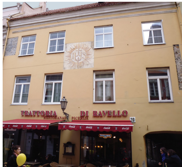
Il. 7. Odkrywki muru i dekoracji malarskich kamienicy w Wilnie, dawniej należącej do Kolegium Jezuitów (fot. E. Świąćka)
