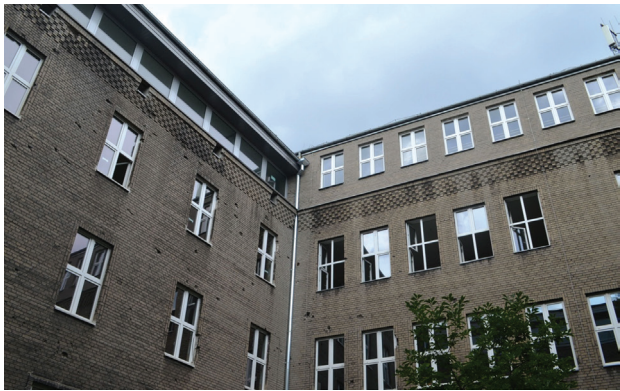
Il. 4. Widok na narożnik nadbudowanego skrzydła zachodniego od strony dziedzińca wewnętrznego (fot. K. Szumiński)
