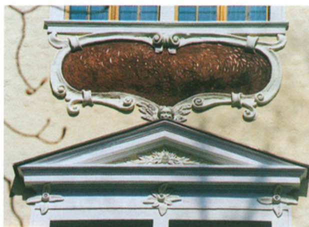
Ryc. 5. Kłasztor w Kamieńcu Ząbkowickim. Fasada. Kartusz pod oknem drugiego piętra
