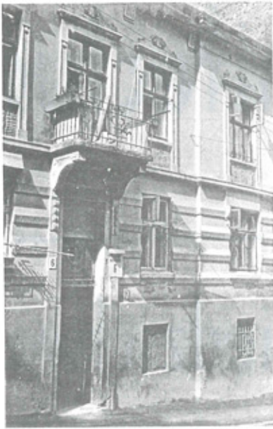
Ryc. 3. Widok dolnych kondygnacji kamienicy przy ul. Ladozkiej 6
