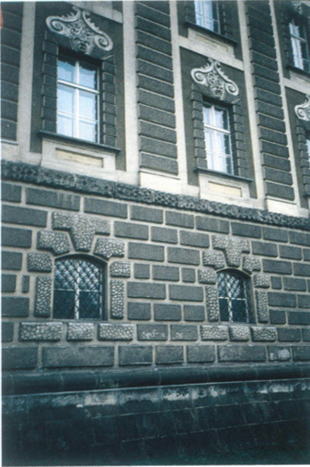
Ryc. 1. Pałac w Żaganiu. Fragment elewacji
