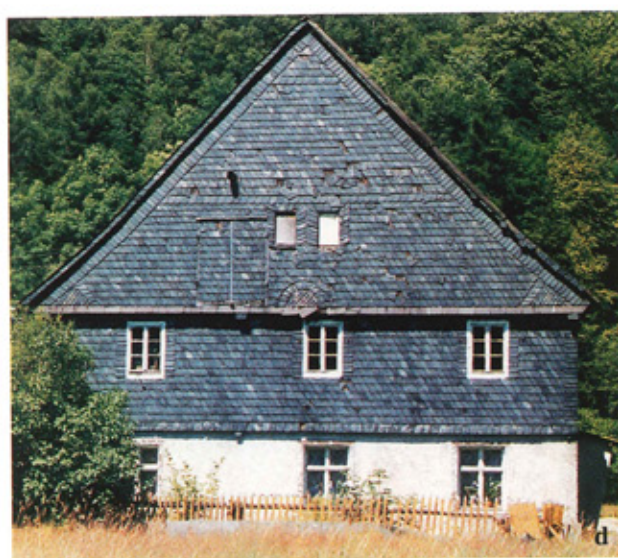
Ryc. 8. Ściany szczytowe opierzone łupkiem: a, c-e) Świeradów, b) Olszyna Lubańska (fot. autorki)
