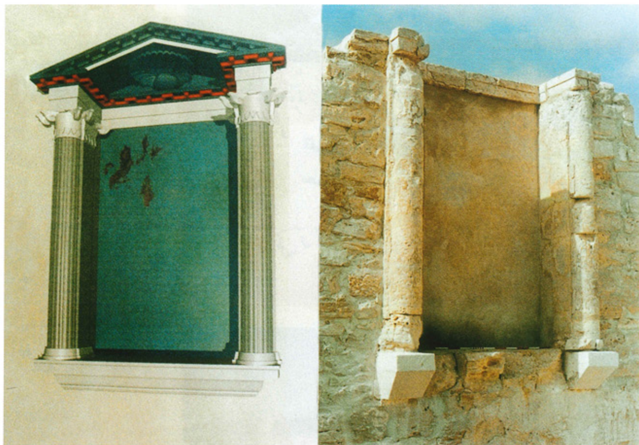
Ryc. 15. Dom H10. Pomieszczenie 2. Nisza – widok od północy. Po lewej rekonstrukcja komputerowa (R. Czerner), po prawej nisza po anastylozie w 1999 r. (fot. P. Zambrzycki)
