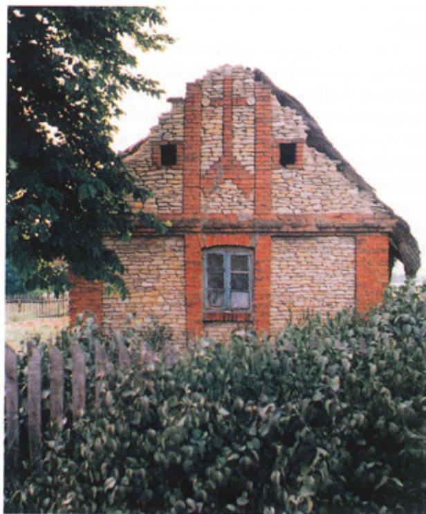
Ryc. 1. Truskawiec k. Gostynina. Detal i kolorystyka ściany szczytowej starej chaty ceglano-kamiennej
