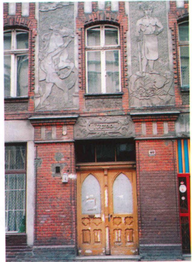
Ryc. 11. Wrocław, ul. św. Antoniego 40. Stan z 1997 r. Secesyjna kamienica ceglano-tynkowana z bogatą dekoracją z dwubarwnego sgraffita
