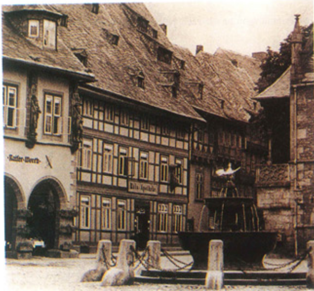
Ryc. 21. Rozwiązanie konstrukcji szachulcowo-ryglowej; dom w Goslar (Niemcy)
