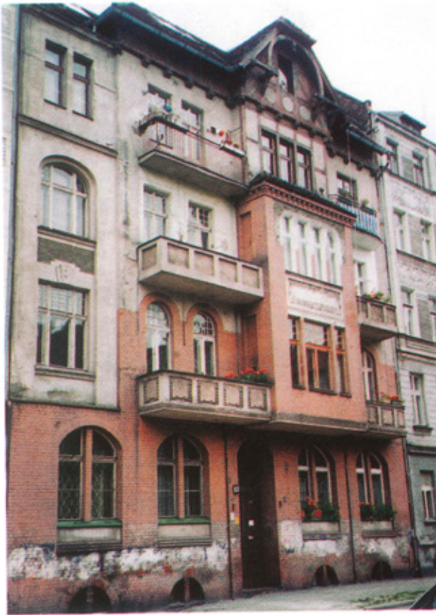
Ryc. 10. Wrocław, ul. Chemiczna 3. Stan z 1997 r. Elewacja z szachulcowym szczytem i drewnianym gzymsem wieńczącym. Fragmenty licowane cegłą pomalowane wspólnie
