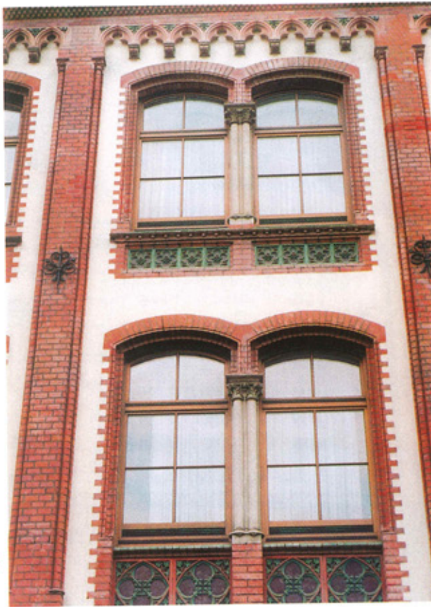
Ryc. 6. Wrocław, ul. Ofiar Oświęcimskich 19. Stan z 1997 r. Odremontowana kamienica ceglano-tynkowana z dekoracją z terakoty i kamienia
