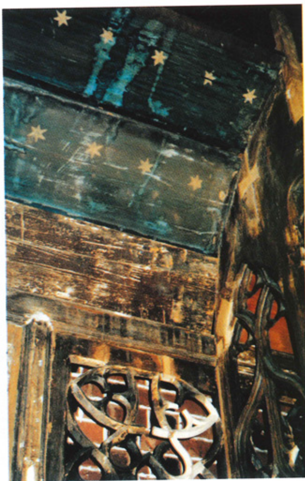
Ryc. 18. Wrocław. Kościół św. Elżbiety – fragment gotyckich stali z XV w. z przykryciem naśladowującym sklepienie, wykonanym z desek pomalowanych na niebiesko ze złożonymi gwiazdami. W toku konserwacji (fot. autora)
