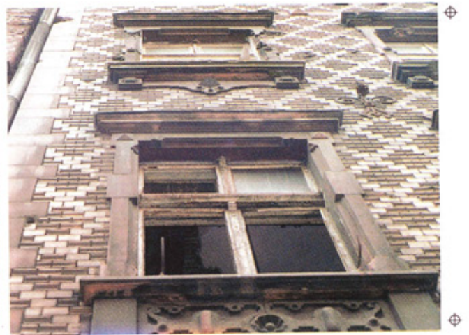
Ryc. 7. Wrocław, ul. Ofiar Oświęcimskich 15. Fragment elewacji z detalami z różowego piaskowca, skonstrastowanymi z wzorem ułożonym z białych i biało-czerwonych cegieł
