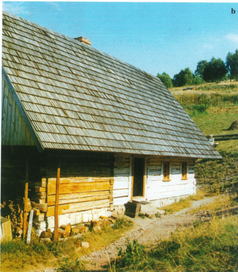
Ryc. 3. Chałupy wieńcowe kryte gontem (skansen Pstrążna): a) karczma z XVIII w., b) chałupa wieńcowa z XVIII w., c) detal (fot. autorki)
