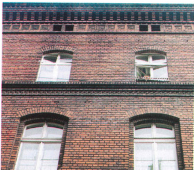
Ryc. 3. Wrocław, ul. Laciarska 34. Stan z 1997 r. Fragment elewacji ceramicznej z kształtek i cegieł w kolorze czerwonym, dzielonej poziomymi pasami z cegieł szklwionych na czarno
