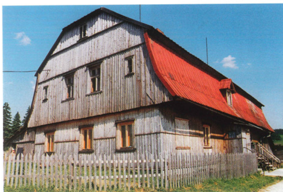
Ryc. 4. Oszalowanie ścian wieńcowych deskami; domy we wsi górskiej Lasówka (fot. autorki)
