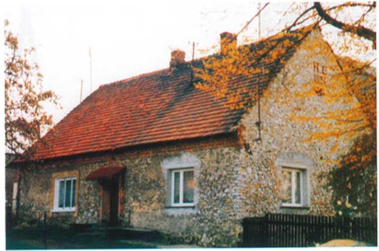
Ryc. 1. Budynek mieszkalny z końca XIX w. w Woli Hankowskiej, jeden z najstarszych zachowanych, zbudowanych z kamienia wapiennego. Są widoczne zmiany i zniekształcenia powstałe podczas rozbudowy i kilkakrotnych remontów (powiększono otwory okienne oraz nadbudowano partię szczytu)
