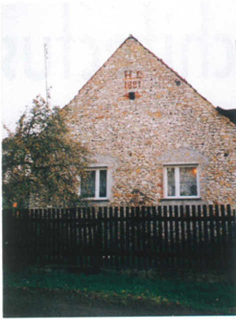
Ryc. 1. Budynek mieszkalny z końca XIX w. w Woli Hankowskiej, jeden z najstarszych zachowanych, zbudowanych z kamienia wapiennego. Są widoczne zmiany i zniekształcenia powstałe podczas rozbudowy i kilkakrotnych remontów (powiększono otwory okienne oraz nadbudowano partię szczytu)
