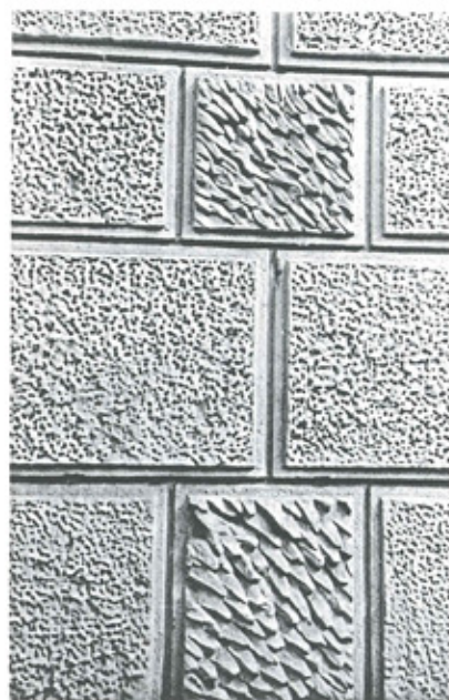
Ryc. 2. Faktura groszkowa i w formie tzw. piór w elewacji kamienicy przy ul. Wałowej 14
