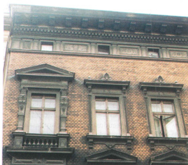
Ryc. 5. Wrocław, ul. Hercena 7. Stan z 1997 r. Pseudostylowa elewacja z cegły łączonej z tynkiem. Gzyms wieńczący z fryzem dekorowanym sgraffitem
