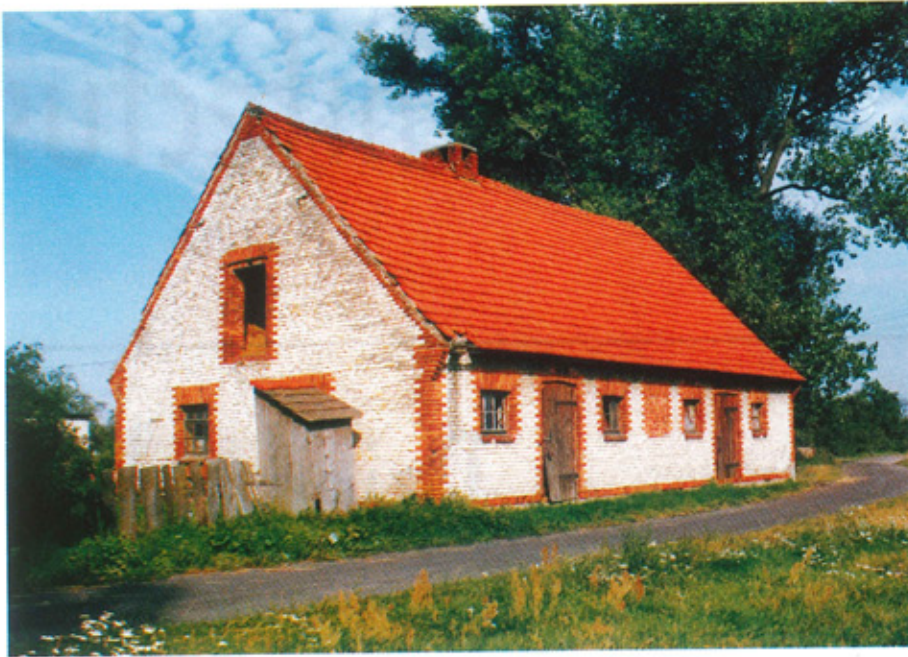
Ryc. 3. Chodów k. Gostynina. Budynek gospodarczy – kolorystyka elewacji
