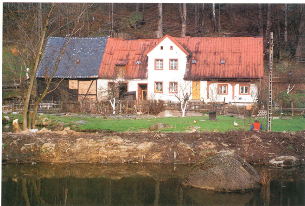
Ryc. 1. Kolorystyka chałupy o konstrukcji mieszanej: ściany przysłupowe w części mieszkalnej, murowane sieni, ryglowe części gospodarczej, odeskowane części składowej, Staniszków k. Jeleniej Góry (fot. autorki)
