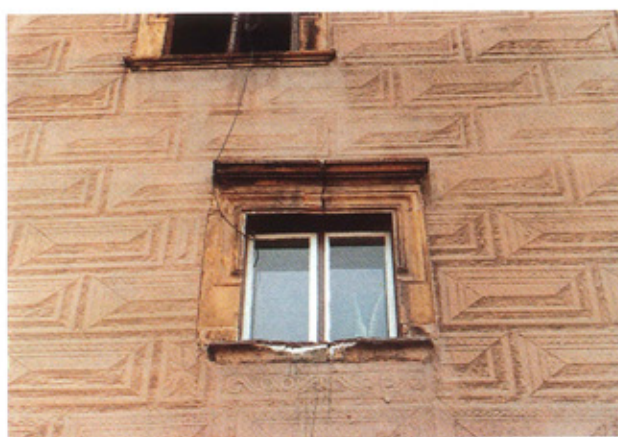
Ryc. 14. Przykład rozwiązania układu boni sgraffitowych na styku z otworem okiennym; dwór w Pawłowicach
