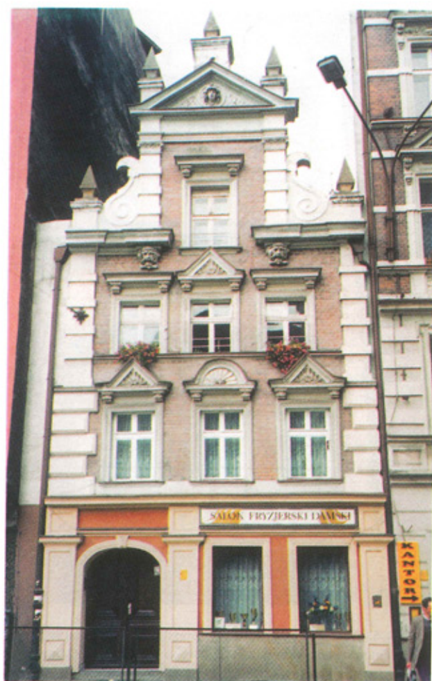
Ryc. 4. Wrocław, ul. św. Mikołaja 42. Stan z 1997 r. Neobarokowa elewacja z cegły łączonej ze sztukaterią i tynkiem
