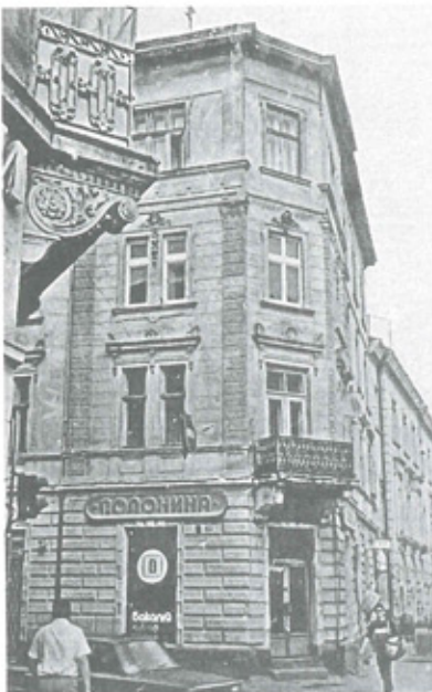
Ryc. 5. Widok elewacji kamienicy przy ul. Szolom-Alejchema 2 d. Bernsteina
