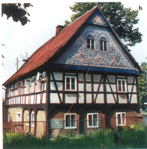
Ryc. 8. Ściany szczytowe opierzone łupkiem: a, c-e) Świeradów, b) Olszyna Lubańska (fot. autorki)
