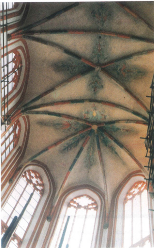
Ryc. 11. Wrocław. Kościół św. Elżbiety – widok i fragment sklepienia chóru po konserwacji zachowanej polichromii oraz fragment nowych cienkich tynków na filarze, w toku prac (fot. autora)
