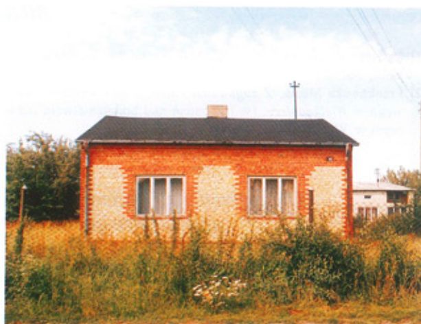
Ryc. 5. Praga k. Poddębic. Zestawienie cegły i kamienia w fasadzie domu mieszkalnego
