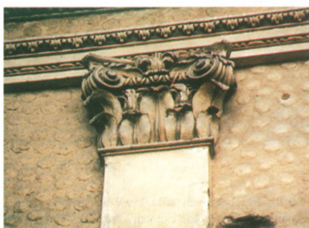
Ryc. 7. Kłasztor w Kamieńcu Ząbkowickim. Fasada. Głowica pilastra i fragment ściany z widocznym krążkowym narzutem tynkowym
