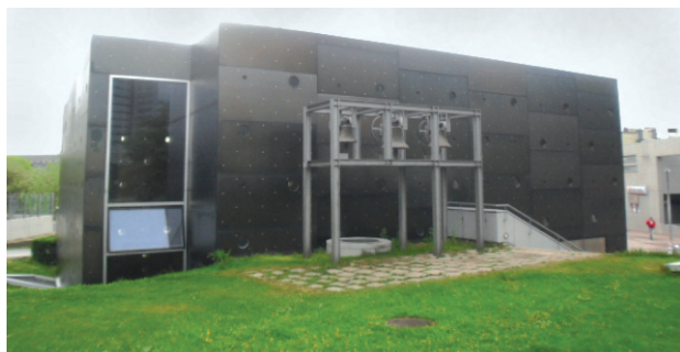
Il. 1. Kościół Chrystusa Nadziei Świata, Wiedeń, Donau City (fot. A. Tejszerska)
